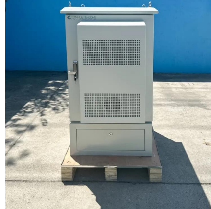
Unión Eléctrica begins the installation of ...
